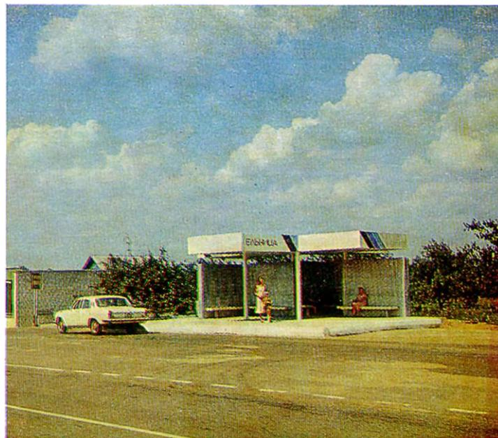
5 сборного автобусного павильона. Крупные конструктивные элементы — стойки, каркасные щиты стен и покрытий — определили строго рациональную форму сооружения. Индивидуализация внешнего облика достигалась различными цветовыми решениями каждого из павильонов.
